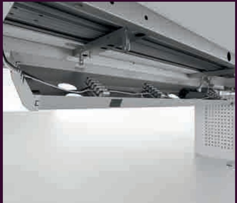
Dettaglio ispezione canale passacavi - Detail inspection cable channel
